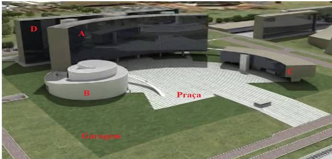
Figura 2 – Maquete dos Blocos ‘A’, ‘B’, ‘C’, ‘D’ e Praça da nova sede do TRF1
